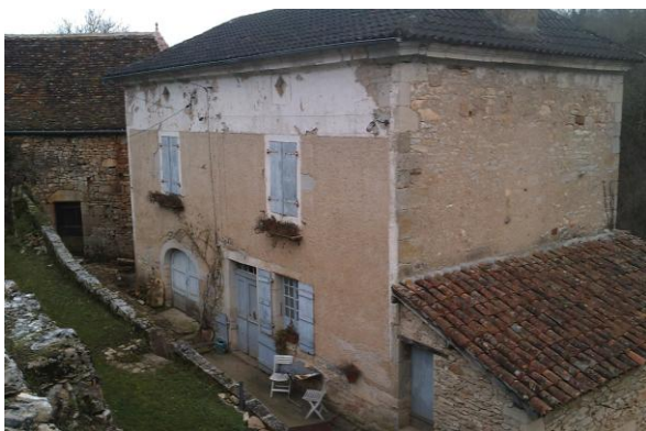
Maison des meuniers Calle
